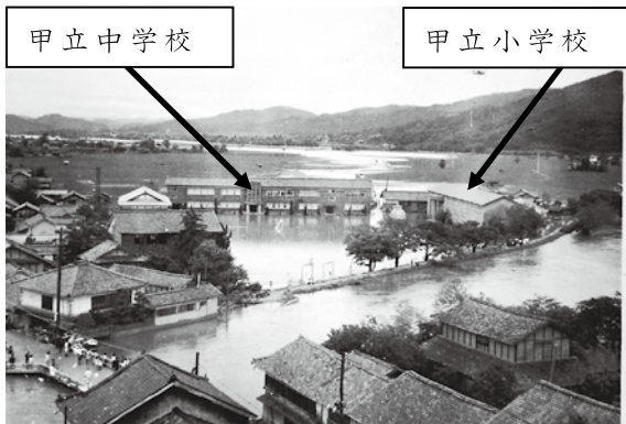
五龍山から五龍橋をのぞむ(甲田町上甲立)
